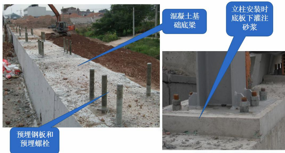
路基段基础：二次浇筑前（左）、后（右）
